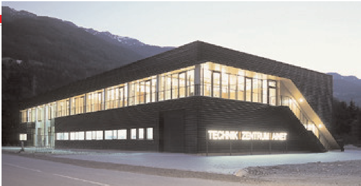
Das Technik-Zentrum Ainet in Osttirol beherbergt u.a. die gesamte mechanische Fertigung
